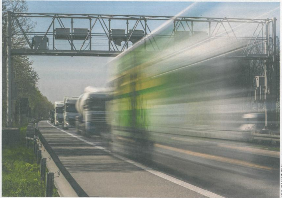
Mautharmonisierung stockt: Als Ausgleich für die LKW-Maut wurden dem Transportgewerbe jährlich 600 Mio. EUR Beihilfen versprochen.
