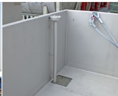
Ein Sumpf ermöglicht es, ausgelaufene Flüssigkeiten nahezu rückstandsfrei abzusaugen.
