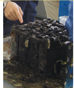
Schwer zu bestimmen: Gefährdungsgrad beschädigter Lithiumbatterien.
