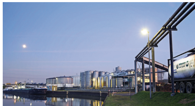
Tanklager von Lanfer im westfälischen Hamm. Hier werden 200.000 Jahrestonnen veredelt und umgeschlagen.
