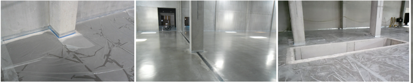
Beispiele aus der Bauausführung: Industriefußboden mit unter dem Beton befindlicher Kunststoffdichtungsbahn und Randblechen (li.), beschichteter Industriefußboden mit Fugenprofilen (Mitte) und Anarbeitung des Industriefußbodens an Grubenbereiche (re.)
