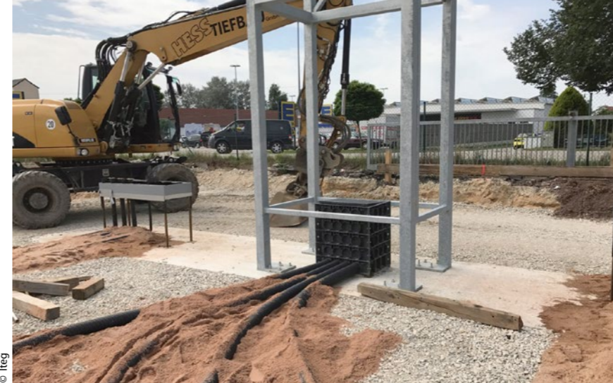
Das Fundament ist statisch so ausgelegt, dass es nicht nur den Technikurm samt Dach trägt, sondern auch die Zapfsäulenrahmen links und rechts davon.
