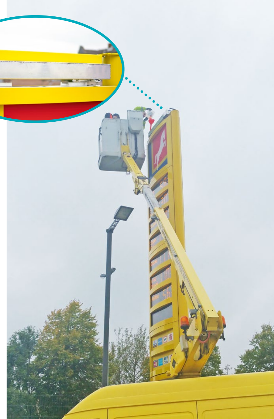
Der Schwingungsdämpfer ist oben am Preismast eingebaut und wird mit einer Flüssigkeit befüllt. Gerät der Turm durch Wind in Schwingung, entstehen im Dämpfer Wellen, die der Schwingung entgegenarbeiten. Dadurch gerät der Turm nicht in Resonanz.
