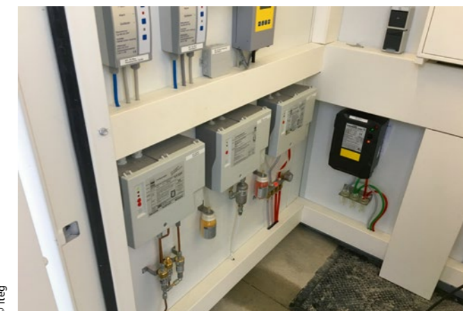
Jeder Zentimeter zählt: In dem kleinen Raum im Technikurm musste die Verteilung der Geräte exakt geplant werden.
