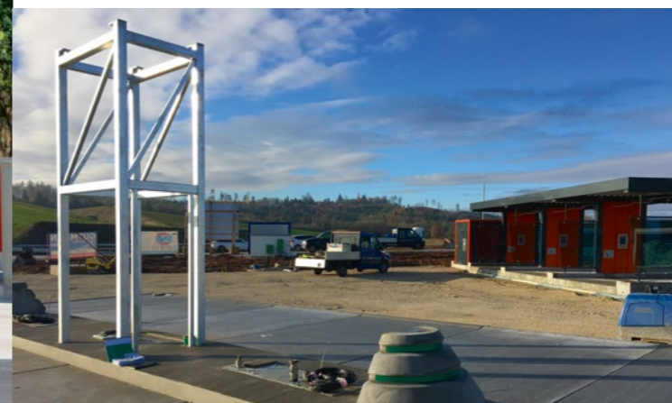
Etwa acht Wochen hat es gedauert, bis die neue Tankstelle fertiggestellt war. Das Investitionsvolumen lag bei 350.000 Euro.
