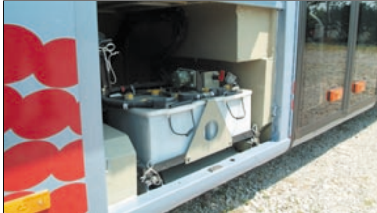
BEQUEM Der Batteriekasten befindet sich hinter der Mitteltür und ist gut erreichbar
