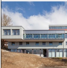
Die Jugendherberge in Überlingen nach der Sanierung
