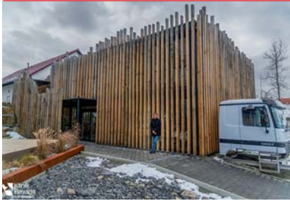
Energiesparen kann man sichtbar machen wie in der Klinik Bavaria in Bad Kissing
